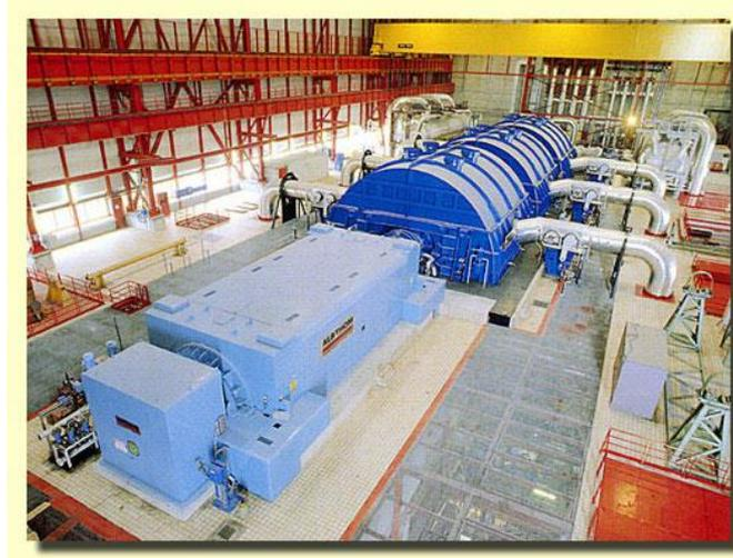
La machine synchrone est réversible et peut également fonctionner en moteur synchrone
